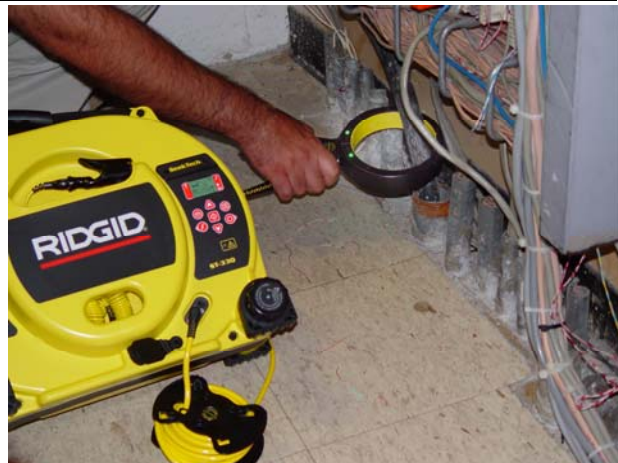
Рис. 16: Индукционный зажим присоединен к кабелю
